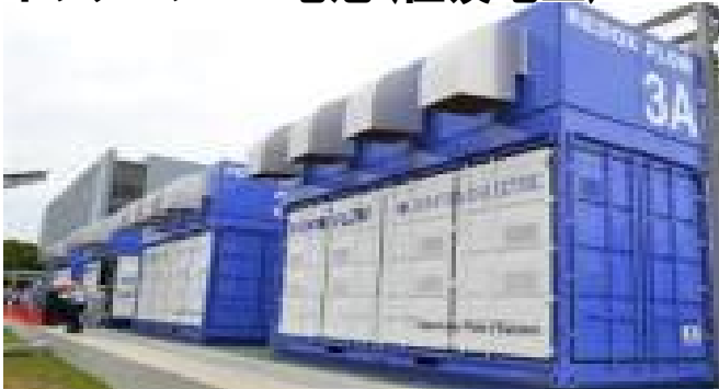
レドックスフロー電池 (住友電工)
