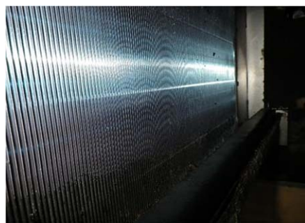
熱交換コイル洗浄後
