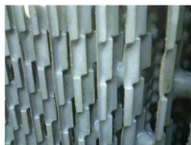
充填材洗浄作業後
