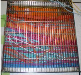
給気口を塞いでいる例
