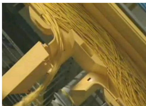
図 3-2i 光コード用ケーブルトレー
